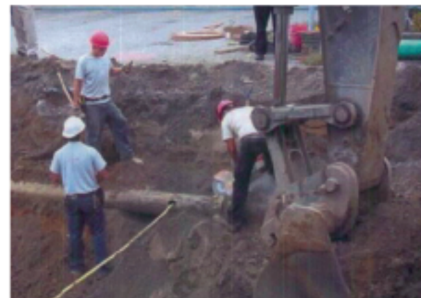
Tuyau de gaz traversant perpendiculairement un tuyau de béton
